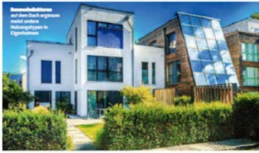
Ein modernisiertes Wohnhaus mit einer effizienten Heizungsanlage.
